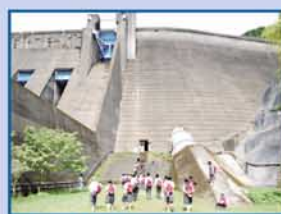
緑川ダムを訪れ、ダムの構造を学びます。
