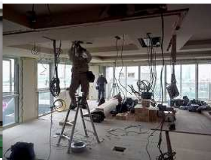
マンションの電気配線工事
