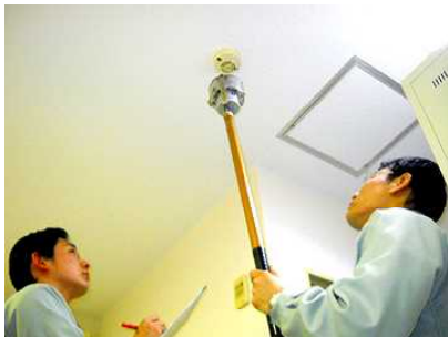
消防設備点検
