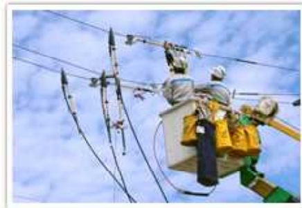
電線の保守・点検・工事
