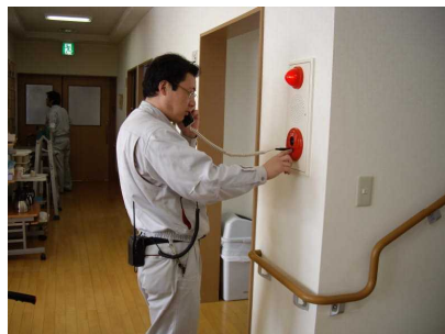
消防設備点検2
