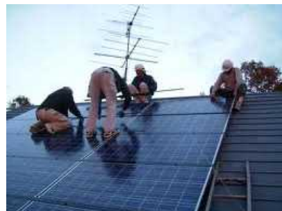
太陽光パネルの設置工事
