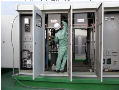
高圧受電設備の工事
