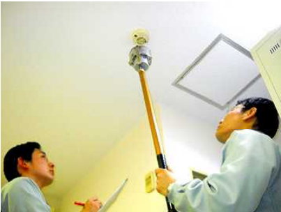
消防設備点検
