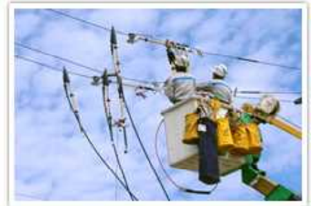
電線の保守・点検・工事
