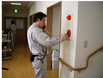
消防設備点検2
