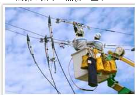
電線の保守・点検・工事
