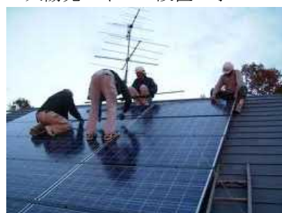
太陽光パネルの設置工事
