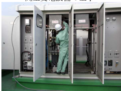
高圧受電設備の工事
