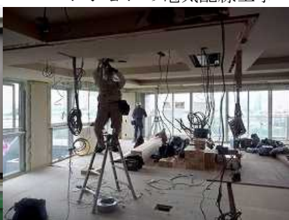
マンションの電気配線工事
