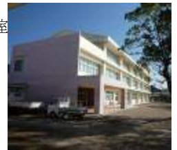
(完成した中学部教室棟)
